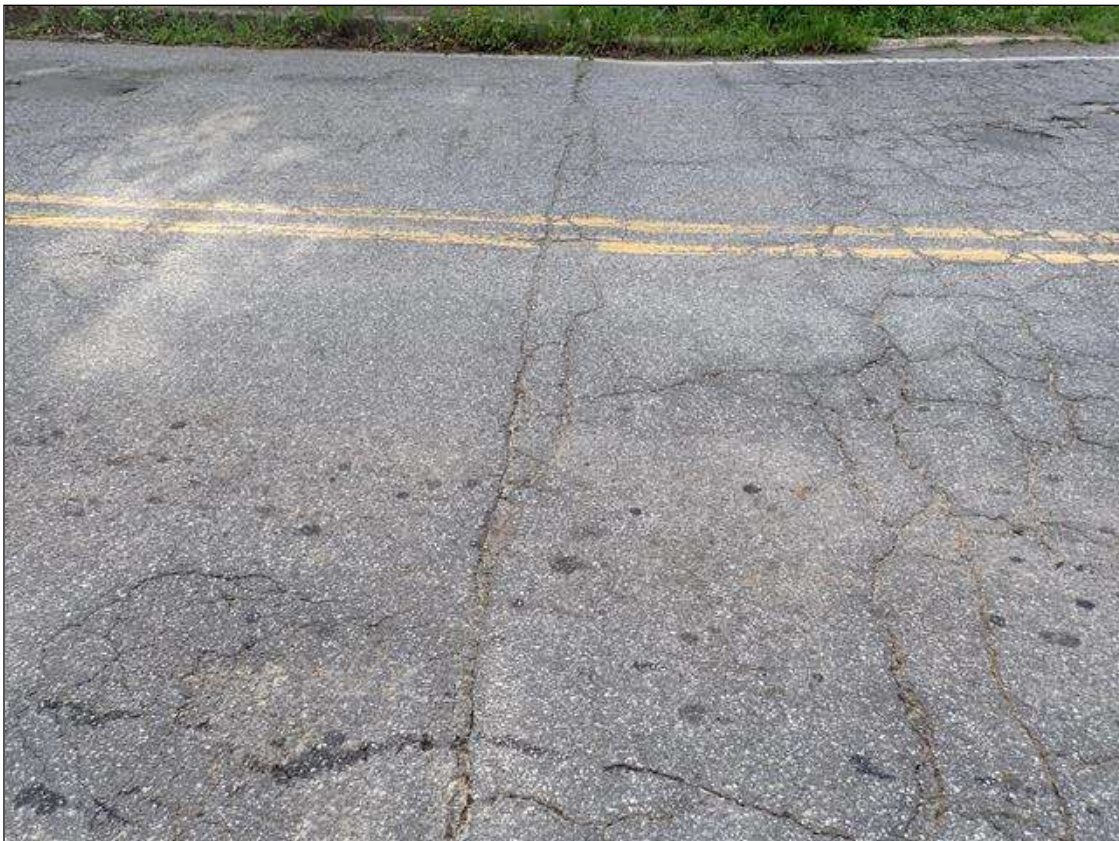
end bent 1 asphalt
