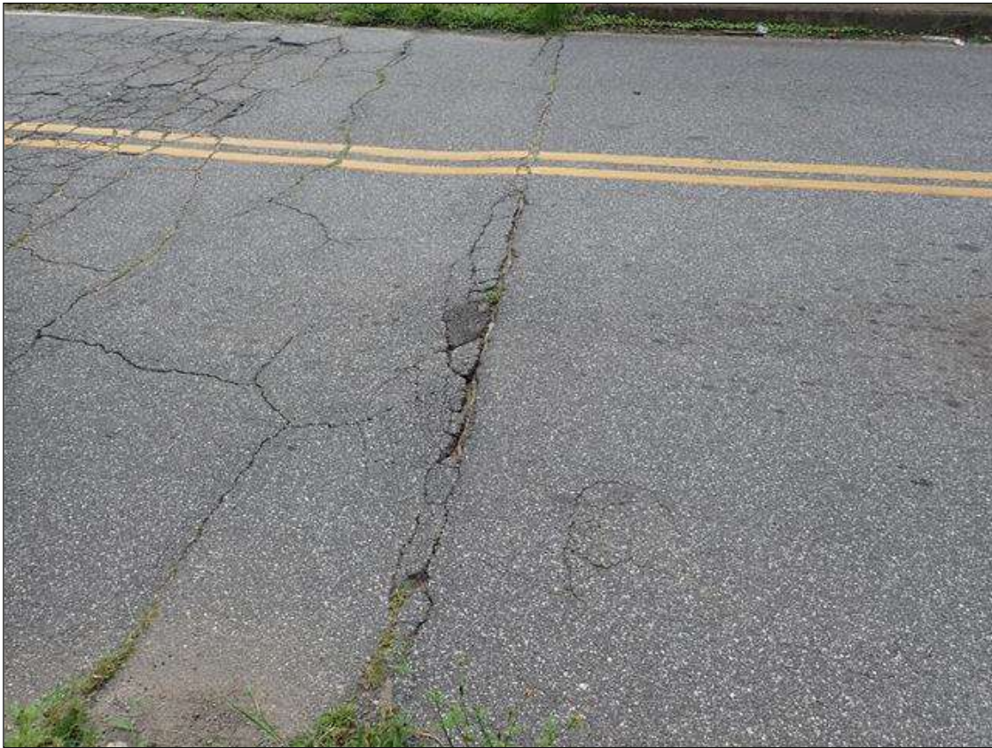
end bent 2 asphalt
