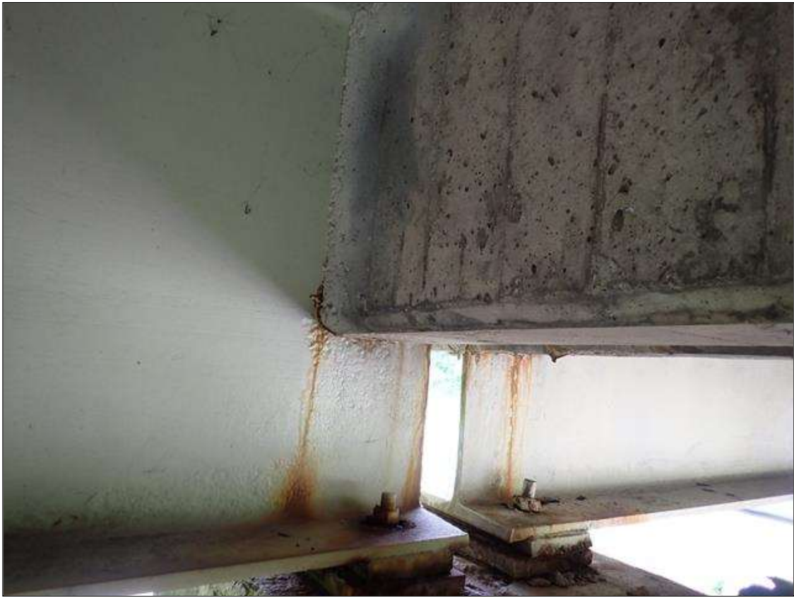
exterior beams over bent 1 (bent 3 similar)
